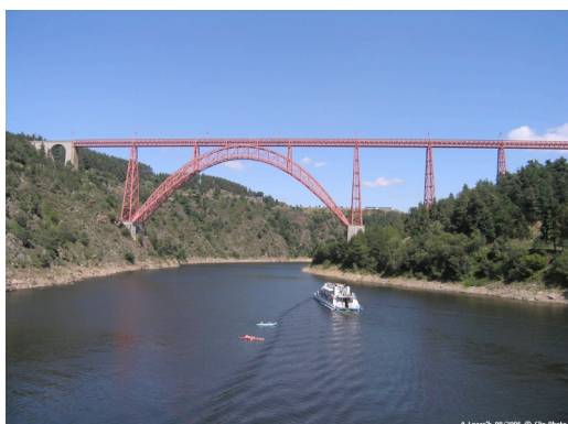
Il ponte ferroviario Garabit (1881-1884), progettato da Gustave Eiffel, è sostenuto da una catenaria riflessa
