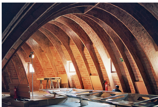
Barcellona, archi di catenaria nell'attico di Casa Milà (1905- 1910) – Gaudì
